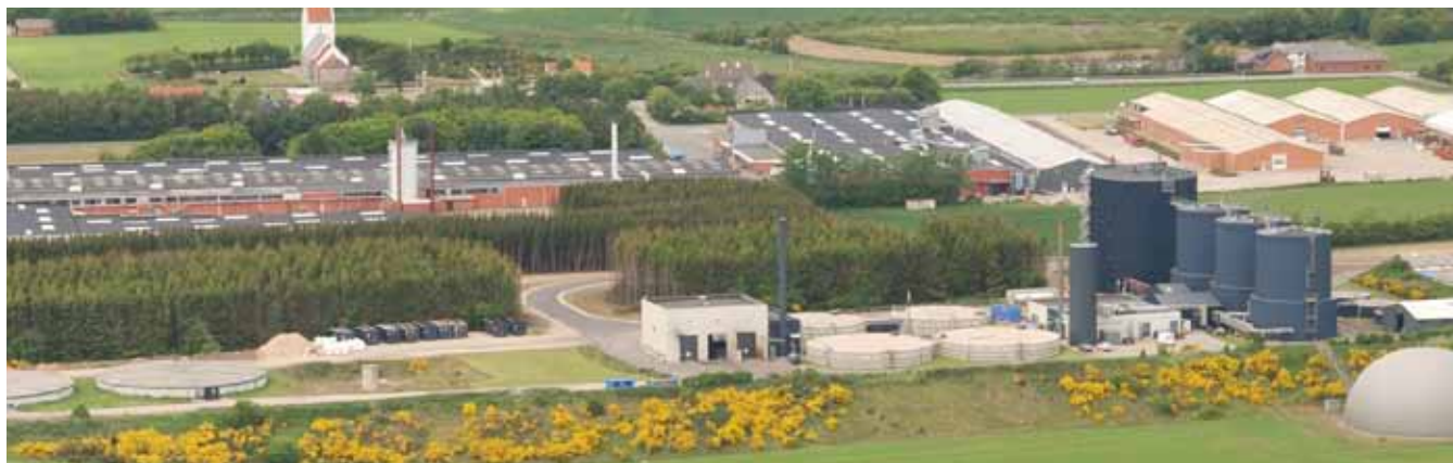
Biogasanlæg ved Lemvig
